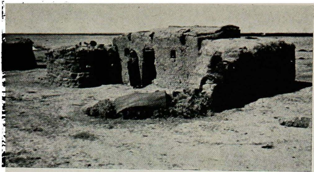
A — GOURBI DE TOUB PRES DU Puits DE BOU HAMADOU.
