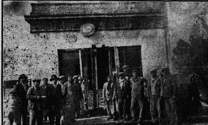
Estado en que quedó la salida de la Federación Obrera Local de Mar del Plata después del estallido de la bomba patronal. En esta fotografía no pueden apreciarse plenamente los estragos causados pues ya los «combros» habían sido retirados y tapados los boquetes que la explosión hizo
